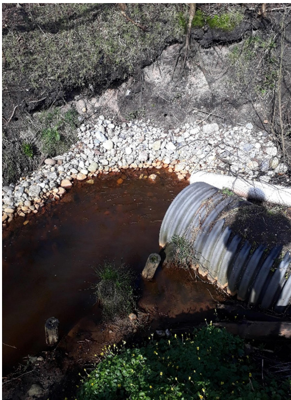
Figur 6 St. 1632 Ved udløbet under Nygårdsvej slår bækken et 90 graders sving. Der er lavet brinksikring ved udløbet, og på det nedstrøms stykke er der rester af faskinpæle. Her laves et stryg for skabe et jævnt fald.
