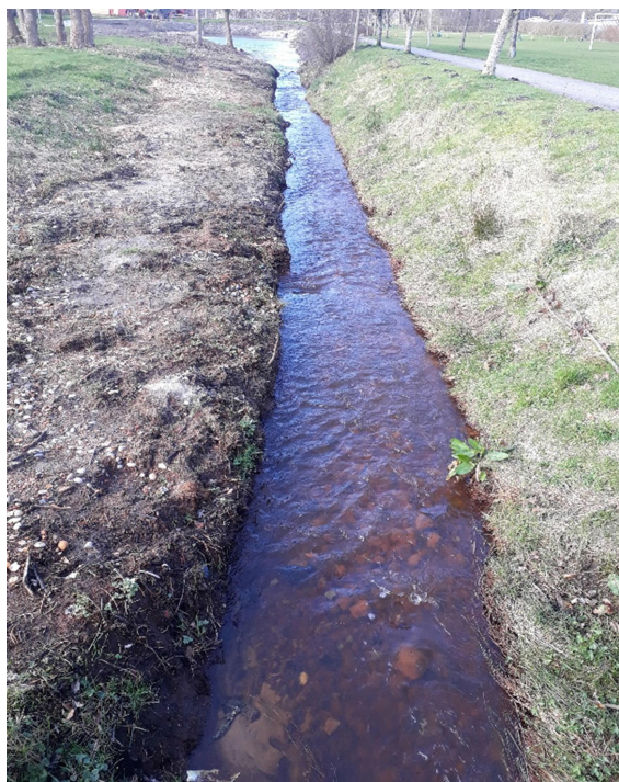
Figur 4 Fra ca. st. 1380 bliver profilet smallere. I forbindelse med renovering af regnvandssø ved Nygårdsvej er der sket en restaurering af bækken med stenet og gruset bund.
